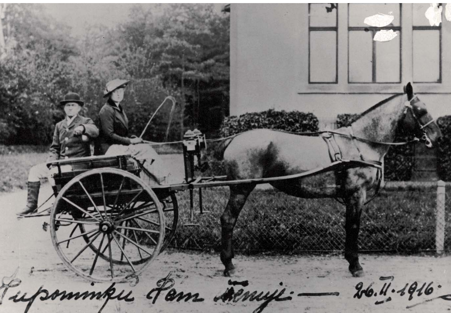
Začátkem 20. století jezdila Erika Heckelová po Pardubicích v tomto vozíku. Vzadu seděl štolba pro případ, že by se kůň splášil.
