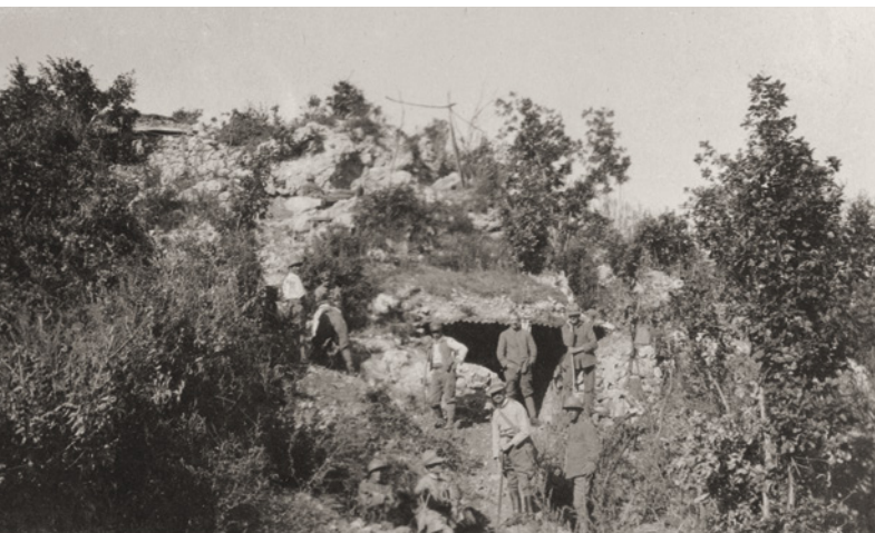
Vstup do kaverny pod kótou 703 Doss Alto
