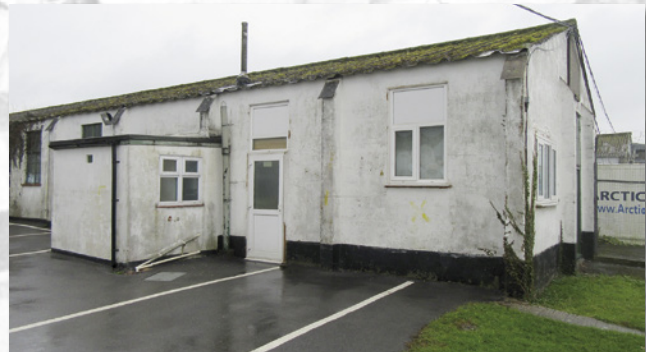
Původní budova z období 2. světové války s poválečnými úpravami
