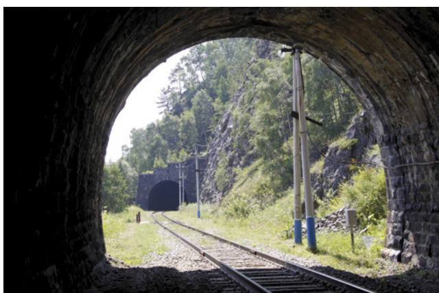
Tunely na staré železnici u Bajkalu
