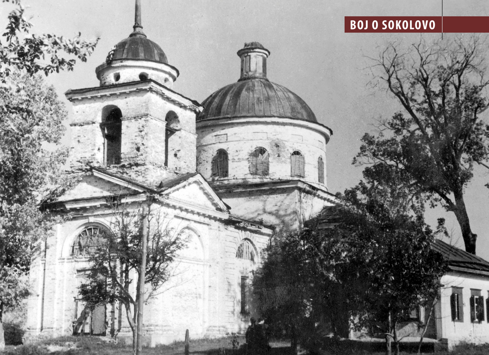
Sokolovský kostelík – centrum obrany 1. roty a velitelské stanoviště npor. Otakara Jaroše. Snímek byl pořízen po válce – na budově jsou patrné zásahy německé dělostřelby. Dnes stavba neexistuje, později byla zbourána.
