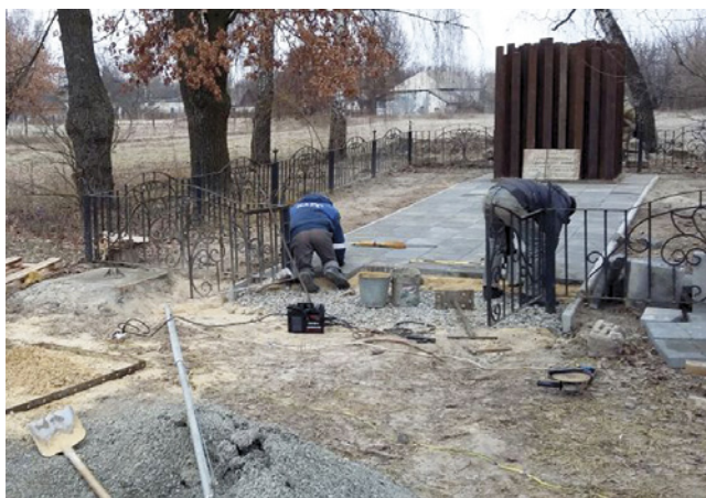
Snímek z poslední kontroly stavby ve Veliké Doči, kterou provedl mjr. Petr Šimák v lednu 2018
