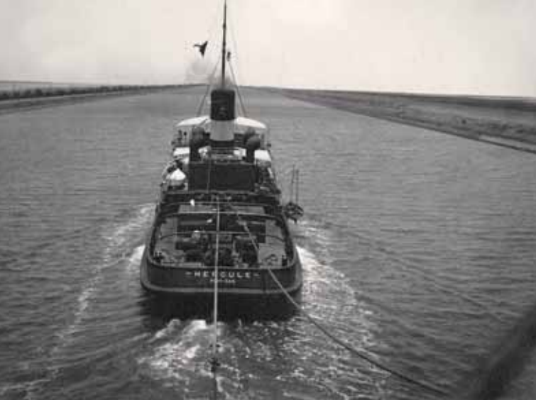
Vlečná loď Hercules, která přetahovala lodí mezi Suezem a Port Saïdem, protože lodní šrouby velkých lodí by rozvířily písčité dno Suezského průplavu. (VÚA-VHA Praha)
