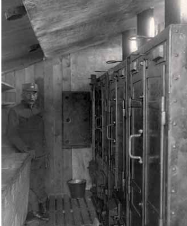
Pece lodní pekárný. (VÚA-VHA Praha)
