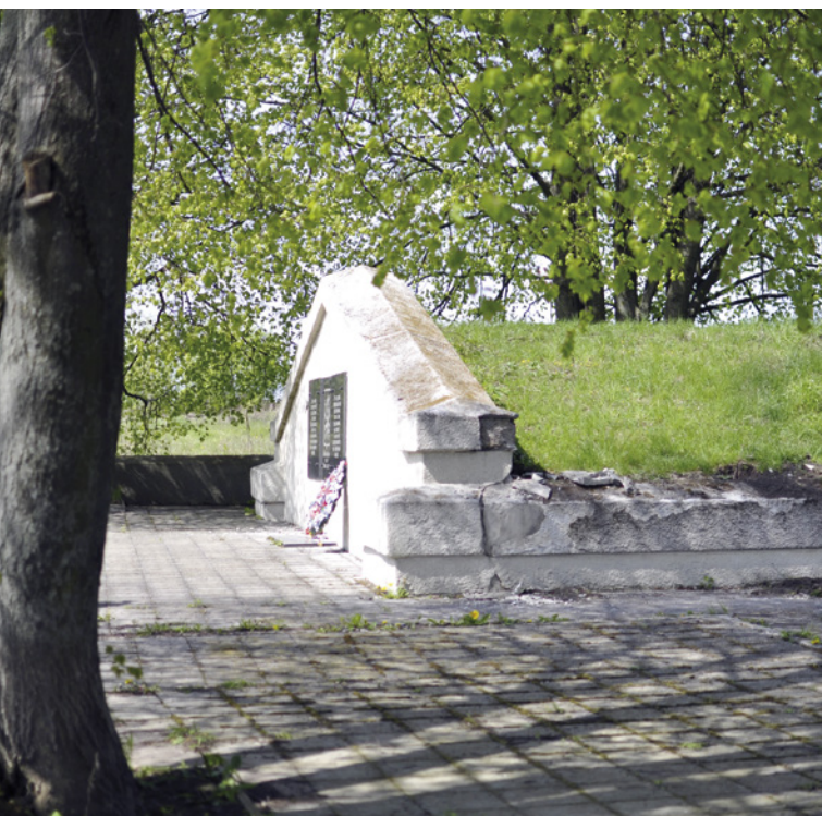
Stav pietního místa před zahájením rekonstrukce byl neutěšený a nedůstojný
