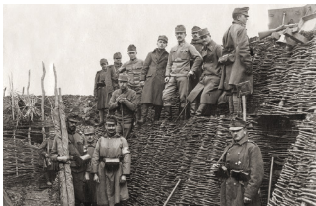
Rakousko-uherské jednotky měly téměř rok na zpevňování a vylepšování zákopového systému před Zborovem. Výsledkem byly tři linie zákopů s proutěným vyztužením, železobetonovými úkryty, kulometnými hnízdy, drátěnými překážkami a minami
