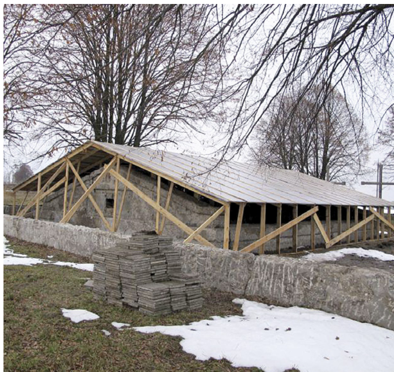
Provizorní zastřešení památníku nad hromadným hrobem zbránilo dalšímu pronikání vlhkosti
