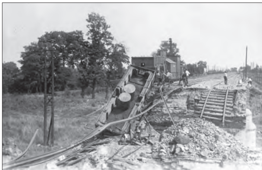
Železničný most cez rieku Nitru v Nových Zámkoch
