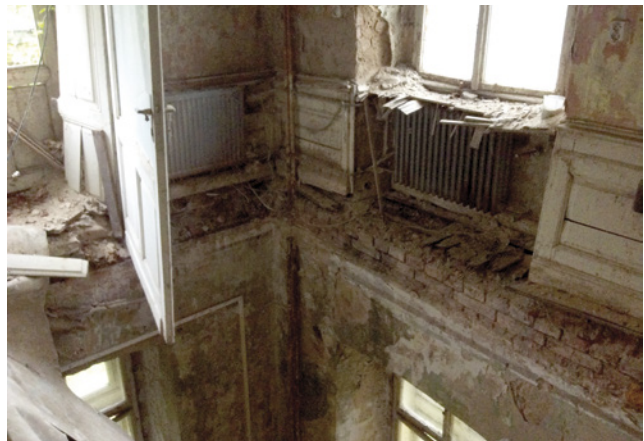
Současný neutěšený stav interiéru věže
